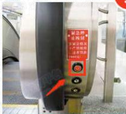
-电梯入口扶手处-
