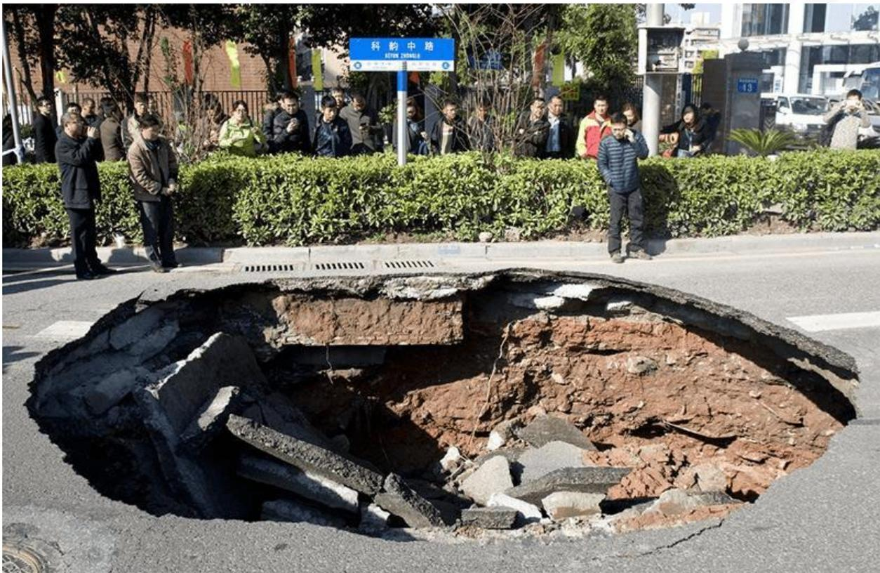
**地陷又称为地面下陷，它是在人类工程经济活动影响下，由于地下松散地层固结压缩，导致地壳表面标高降低的一种局部的下降运动（或工程地质现象）。**
